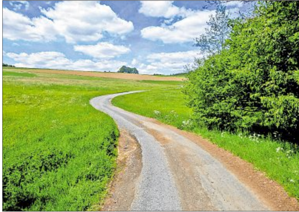
In Netphen gibt es insgesamt 1300 Kilometer Wald- und Wirtschaftswege. Viele von ihnen werden jetzt begutachtet. Foto: Verwaltung
