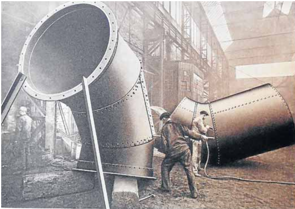
Auf einem der gezeigten Fotos war das Nieten mit Presslufthämmern zu sehen.
