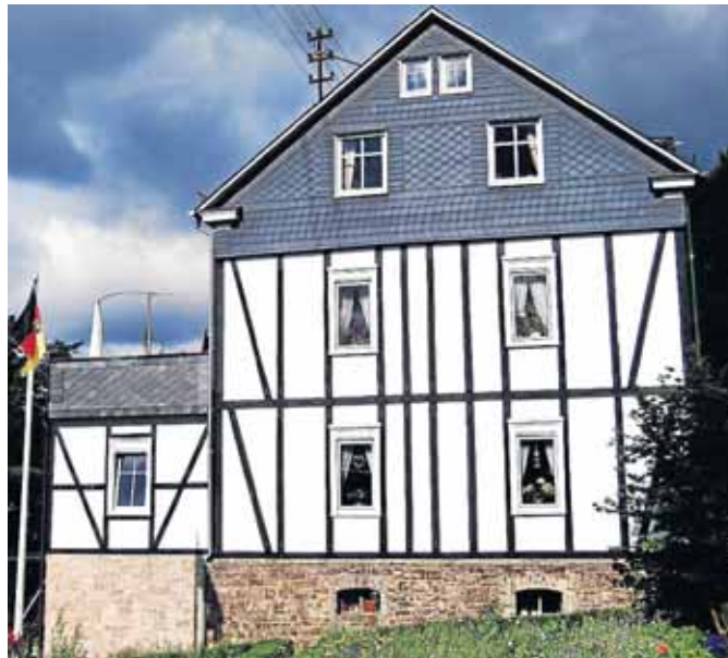
Das Grissenbacher Fachwerkhaus „Schöerlersch Hus“ (Siegentalstraße 50) ist heute noch vorhanden.
