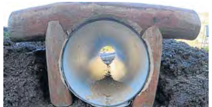
Das beschichtete Rohr ist fünfeinhalb Meter lang und wurde von der Firma Eisenbau Krämer aus Kredenbach zur Verfügung gestellt.
