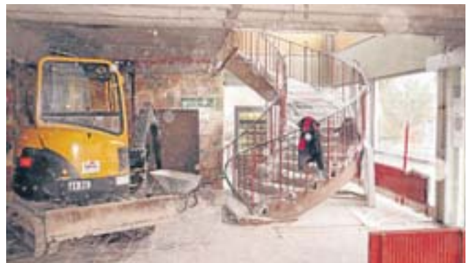
Ein Bagger im Bad: die aufwändigen Abbrucharbeiten.
